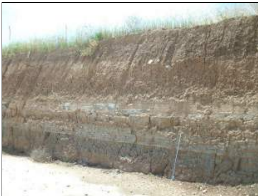
Figura 8 Talud de arcillas en capas horizontales
